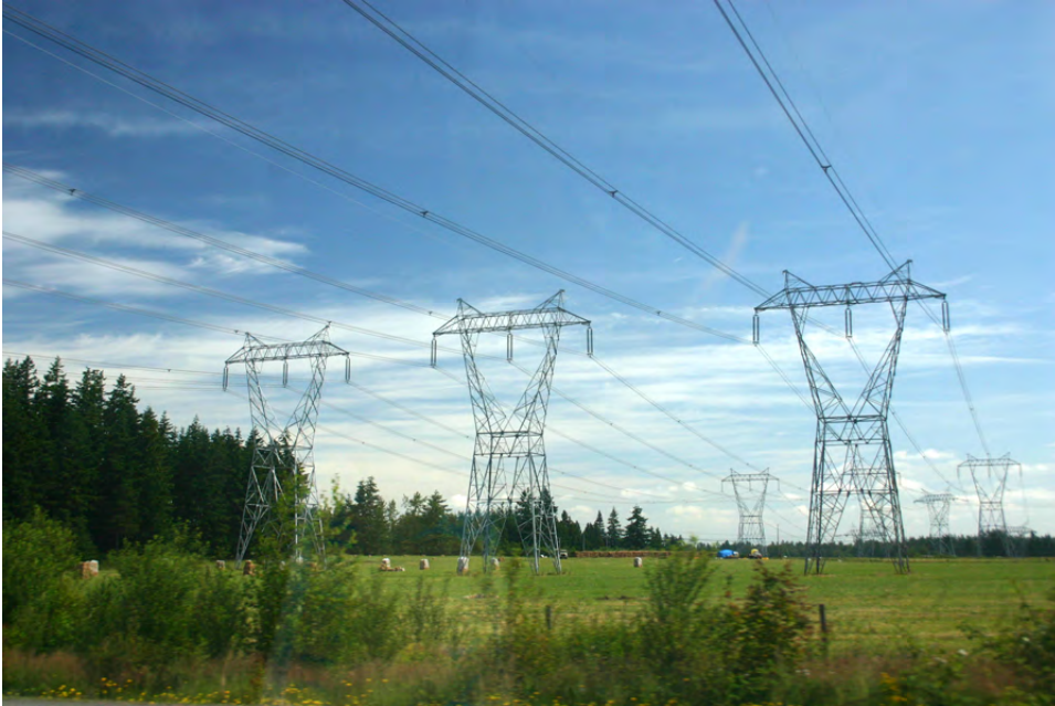
Líneas de distribución de potencia trifásica. 1
